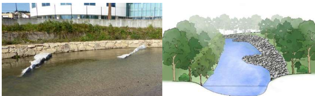
Figura 44 – Defletor de corrente (fotografia e alçado)
