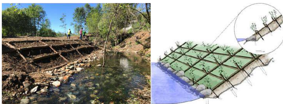
Figura 42 – Grade viva (fotografia, secção transversal e alçado)
