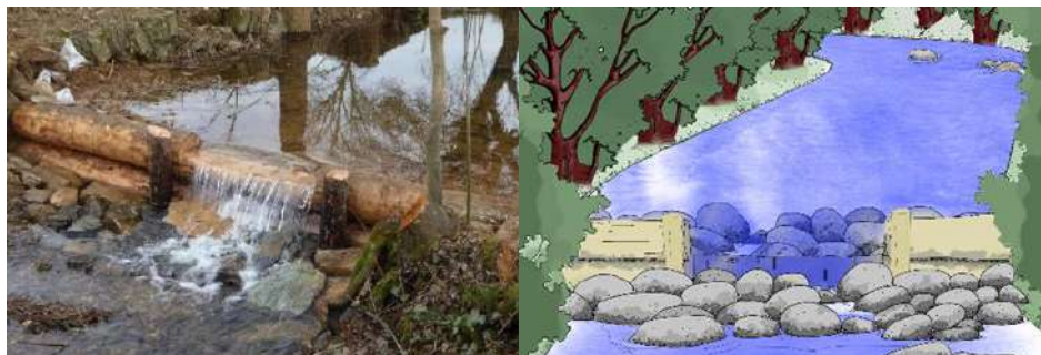
Figura 30 - Travessão em pedra e madeira (fotografia e secção transversal)
