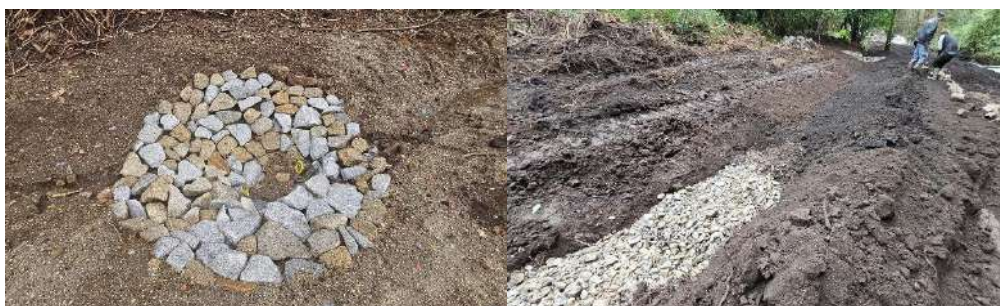
Figura 31 – Exemplo de sistema de micro-charcos conectados por biovaletas
